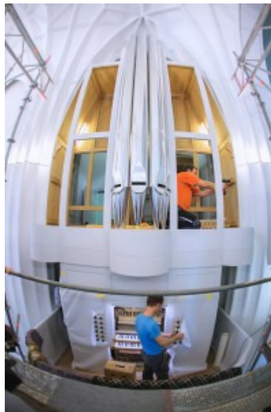
Die Firma Metzler aus der Schweiz baut derzeit die neue Schwalbennestorgel im Paulinum - Aula/Universitätskirche St. Pauli ein. Foto: Swen Reichhold
